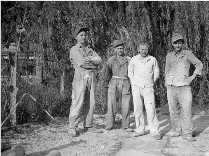
Arbeiter nach dem Krieg aufgenommen am Lagerplatz Zedernstraße 7. von links: unbekannt, Rudolf Raumer, Georg Hörath, Großkopf.
